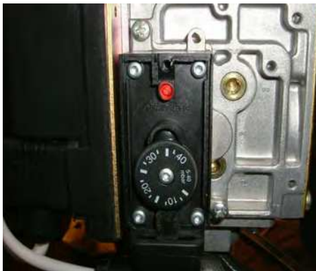
Figura 8.1.2 - Presostato de mínima presión de gas
